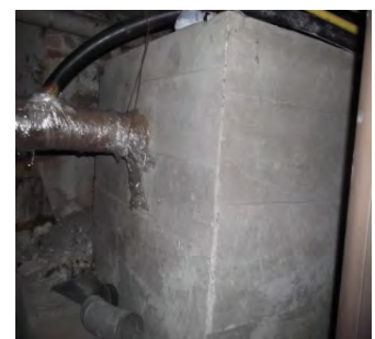
Au sous-sol de la maison
