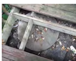
Sous une structure
